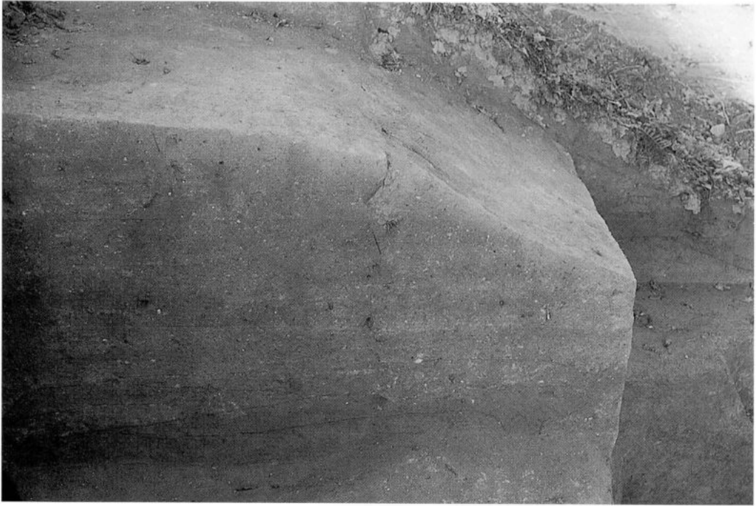
[사진 21] 처인성 남문지 내측 서쪽 기둥구덩과 중간 기둥 사이의 판축층 모습
