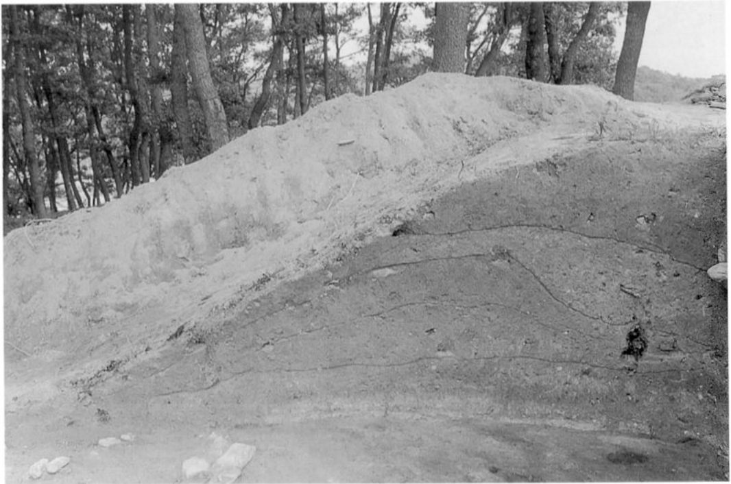
[사진 12] 처인성 남문지 성내측 동측벽 판축 토층 모습
