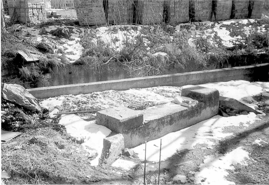
사진 III-7. 수려선의 궤도자리: 1931년 가설된 수려선은 수원역을 출발하여 신갈, 김량장, 양지, 이천 등을 경유하여 여주에 이르는 연장 73.4 km의 증기 및 가솔린 병용의 궤간 0.762m에 불과한 협궤철도였다. 경기내륙의 동서간 교통로로 중요하였던 수려선은 자동차교통시대의 도래와 함께 1973년 폐지되었다. 노선을 따라서는 곳곳에 과거 궤도가 놓였던 흔적이 남아 있다.
