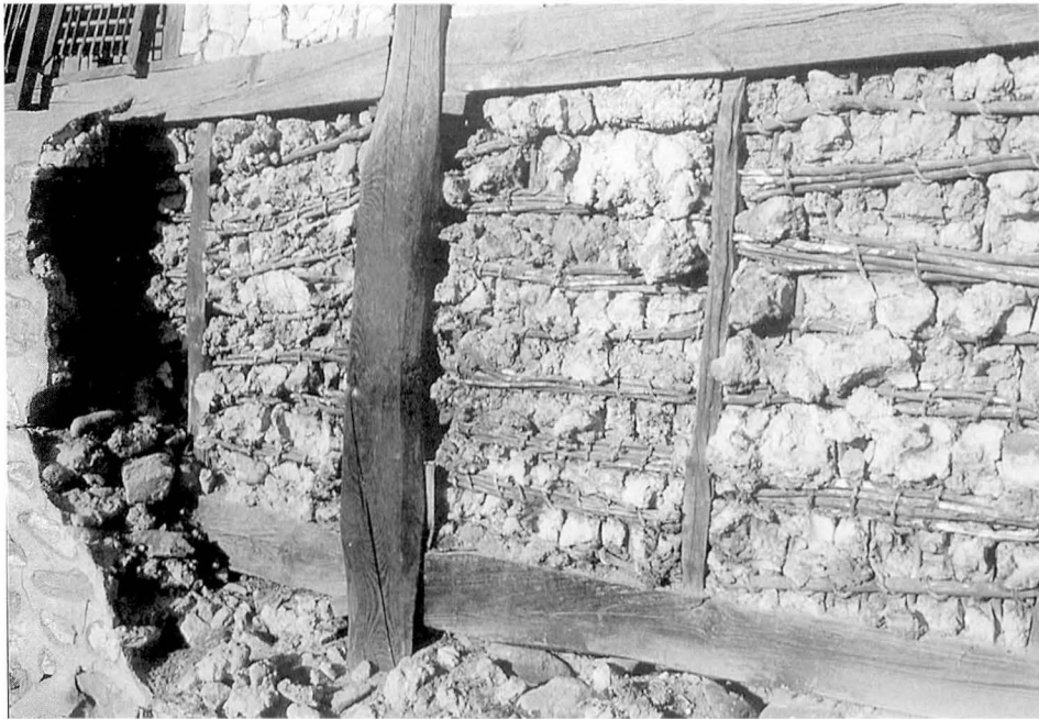
사진 IV-19. 가옥의 벽체 : 갈담리 갈월마을 이영희씨 집의 벽체이며, 나뭇가지를 엮은 다음 진흙을 발라 만들었음을 알 수 있다.
